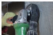
staubfreies Schleifen von Fliesenkleber
